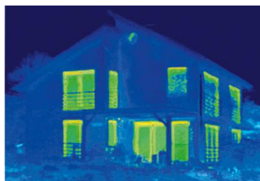
Po ciepłym montażu nowych okien w systemie Schüco FocusIng badanie termograficzne wykazało poprawę efektywności energetycznej budynku. Straty ciepła zostały niemal całkowicie wyeliminowane.
